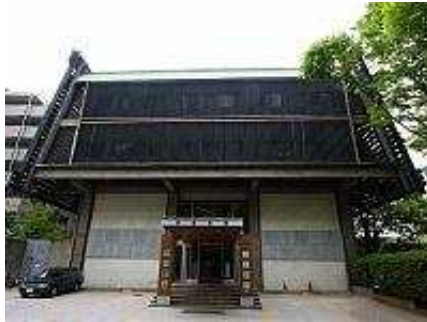
GAMBAR 4. 14 BANGUNAN SUGINAMI MUSEUM
