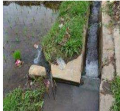
Gambar 2.3 Pembagian Air dengan Sistem Tektek
